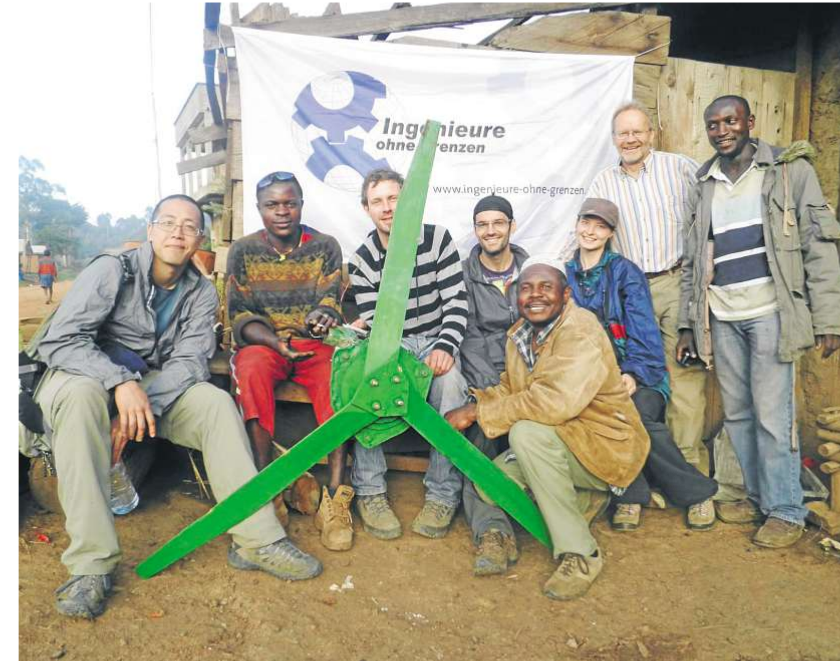
Auf der Durchreise reparierte das Team von Ingenieure ohne Grenzen und Green Step spontan eine alte Windkraftanlage. Bryan Ho-Yan, Björn Pucher, Johannes Hertlein, Petra Kürzinger und Stefan Krebs (von links) freuen sich, den Kamerunern bald noch mehr helfen zu können. Fotos: Ingenieure ohne Grenzen
