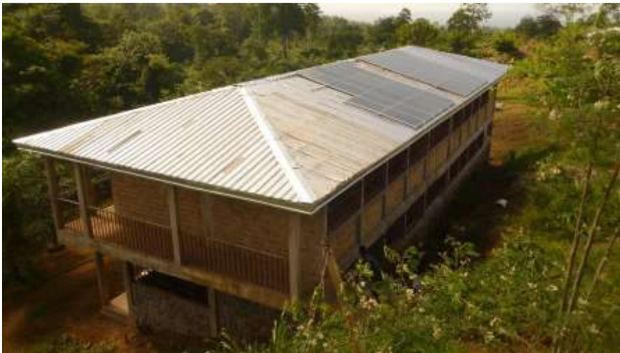
Installation einer Solaranlage bei HOTPEC, 2014
